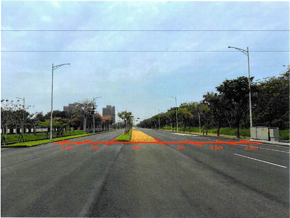
圖 3 建成路測試區段(東側)道路現況圖
